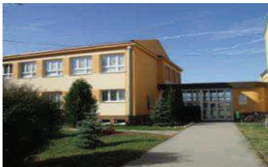
Budova základných škôl obce
